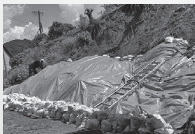
▲宇城・美里地区の組合員宅の泥かき支援。職員とワーカーズ計13人が参加。倉庫に流れ込んだ土砂を掘り、土砂が堆積しているところにブルーシートを被せ、土嚢で固定しました。被災された組合員の方は、「被災したことがショックで身体がついていけないところ、皆さんが駆けつけてくださって大変助かりました」と感謝されていました。(8/23)
